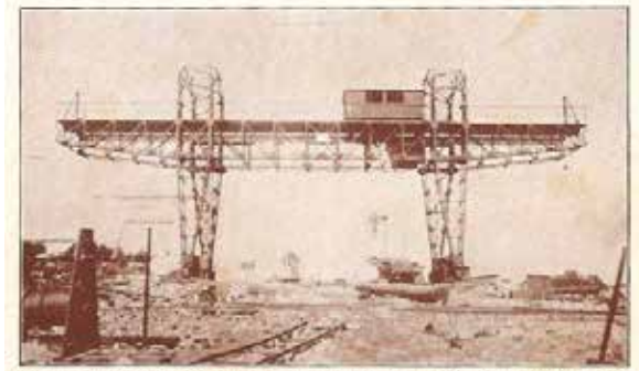
L'énorme pont-roulant, lors de levage 30 tonnes, écartement 32 mètres, hauteur utile 12 mètres, voie de roulement 300 mètres, aux Grandes Carrières de Marbres de Louis de la Société Anonyme "MARBRONYX", à MONTMEYAN (Var), France.
