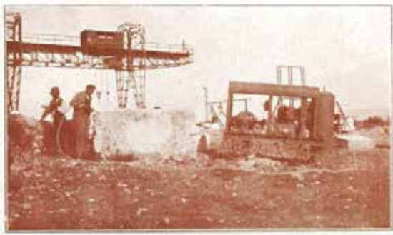
Essai de blocs au moteur à air comprimé, aux Carrières de Marbres de MONTMEYAN (Var), de la Société Anonyme "MARBRONYX".
