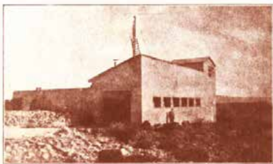
Cabine et transformateur électrique, atelier et bassin d'eau d'une capacité de 300.000 litres, aux Carrières de Marbres de MONTMEYAN (Var), de la Société Anonyme "MARBRONYX".
