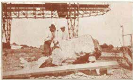
Évacuation de blocs à la main, aux Carrières de Marbres de MONTMEYAN (Var), de la Société Anonyme "MARBRONIX".
