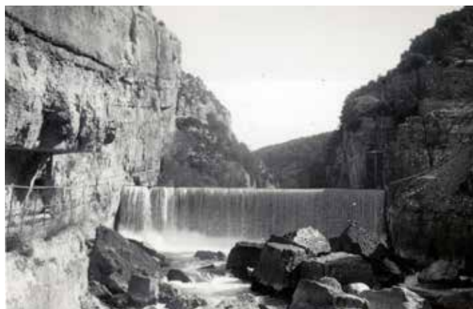
Barrage sur le Verdon
